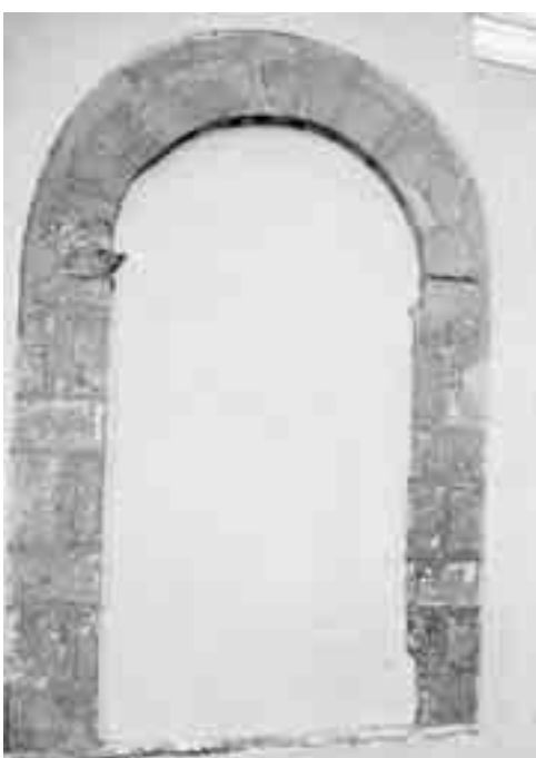
LA PORTA CHE COLLEGAVA IL CHIOSTRO E LA CHIESA
